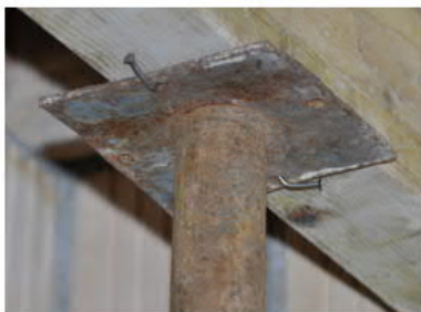
2 Korrekt vernagelte Kopfplatte
