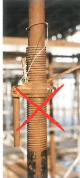
4 Armierungseisen = ungeeigneter Steckbolzen
